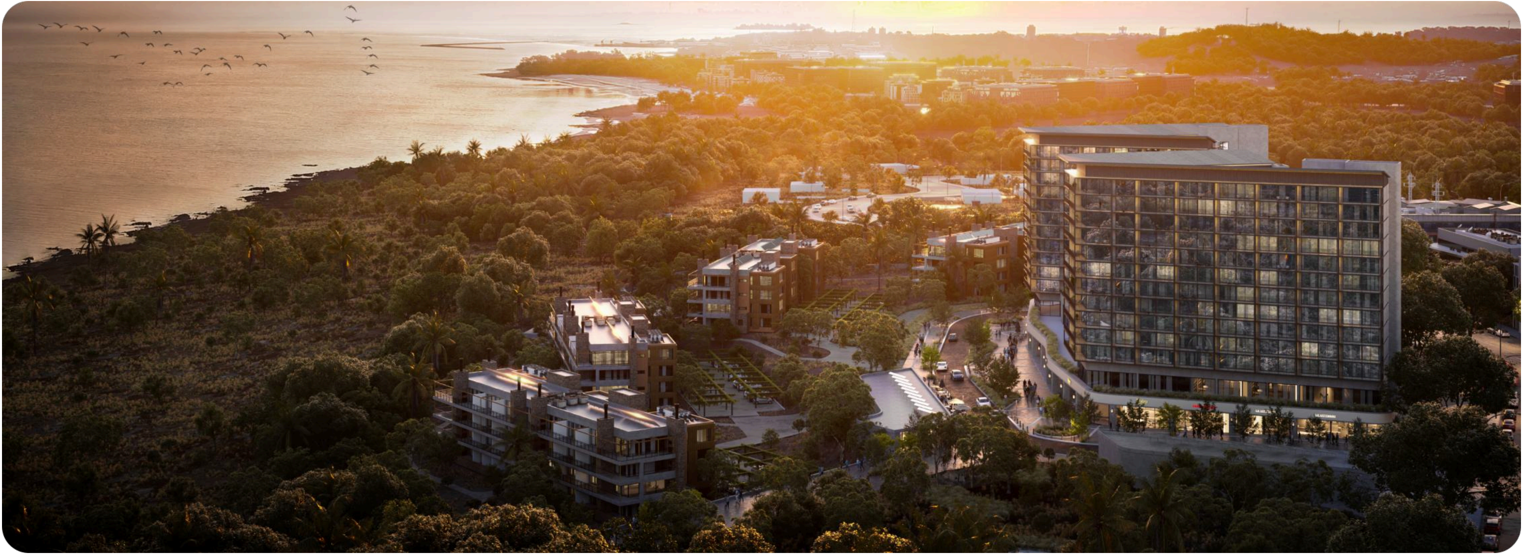
Quartier +Colonia (En obra) Colonia
